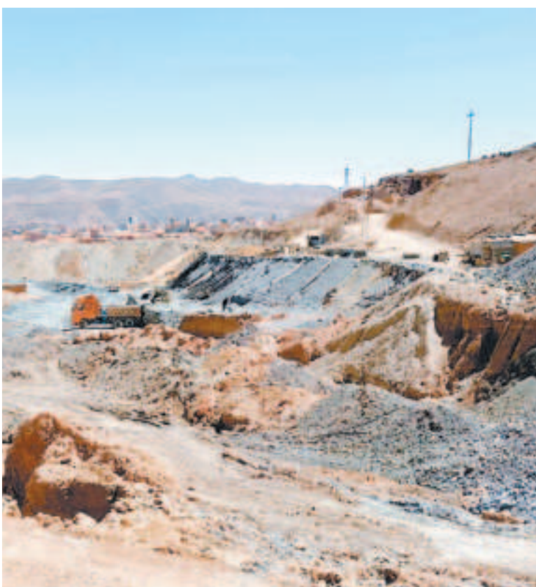
Actividades de relleno en el Cerro Rico.
