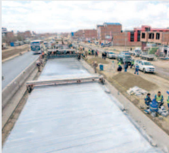
La vía La Paz-Oruro, tramo Senkata-Apacheta, donde se construyen ocho carriles.
