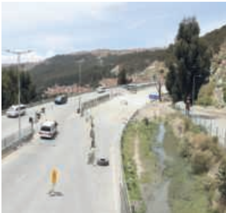
Los trabajos en la autopista La Paz-El Alto.
