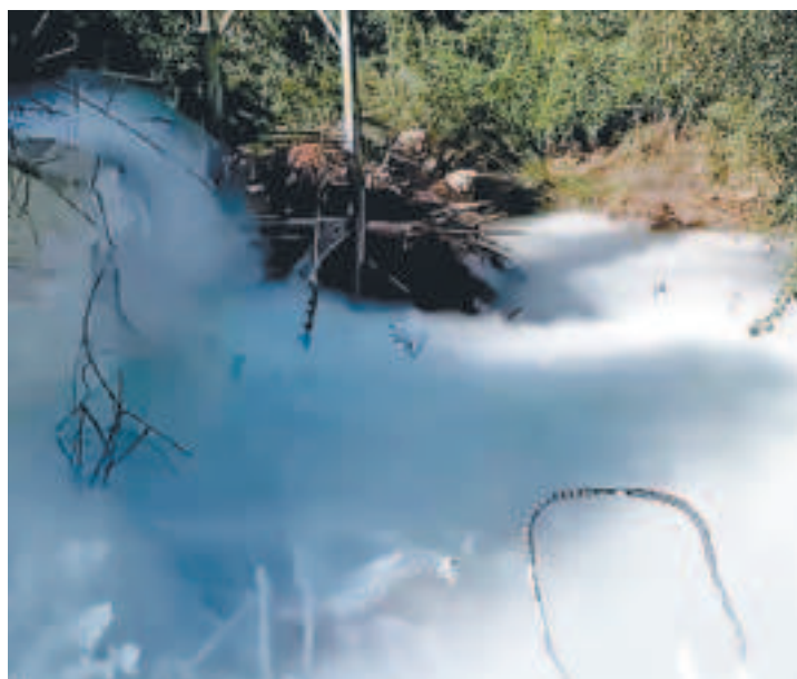
El gas que se expandió en Samaipata luego de que un árbol dañara un oleoducto.
