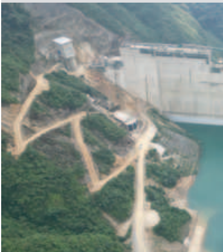
La presa Sehuencas, del proyecto Ivirizu.
