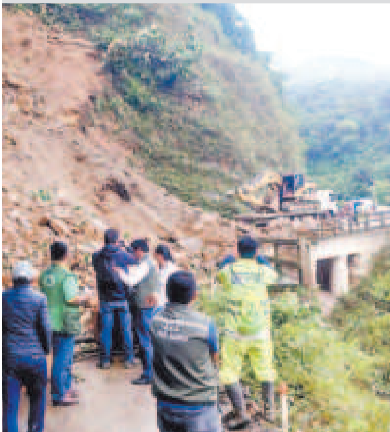
Un deslizamiento en los Yungas de La Paz producto de las lluvias.
