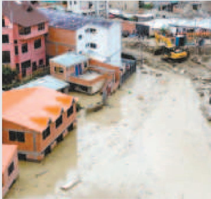
Viviendas afectadas por el deslizamiento en Bajo Llojeta el año pasado.
