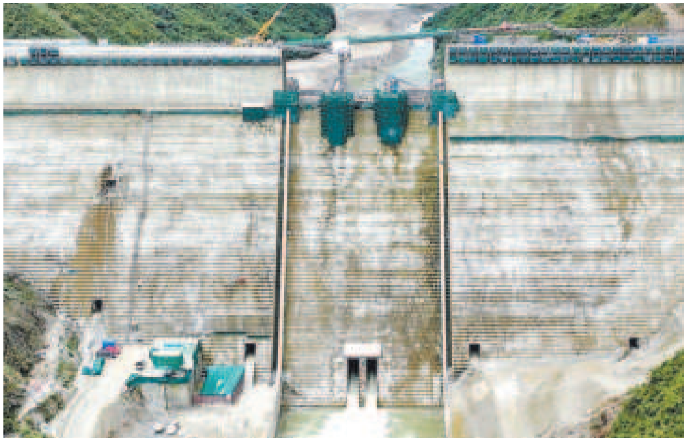
La hidroeléctrica Ivirizu, ubicada entre las cuencas de los ríos Ivirizu y Cristal Mayu, que son parte de los municipios cochabambinos de Tiraque, Titora, Pocona y Vacas.
