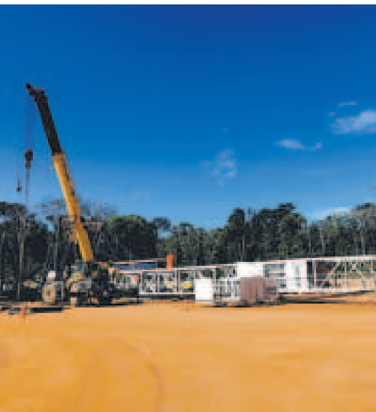
Movilización del equipo para perforar el pozo Tomachi-X1 IE.
