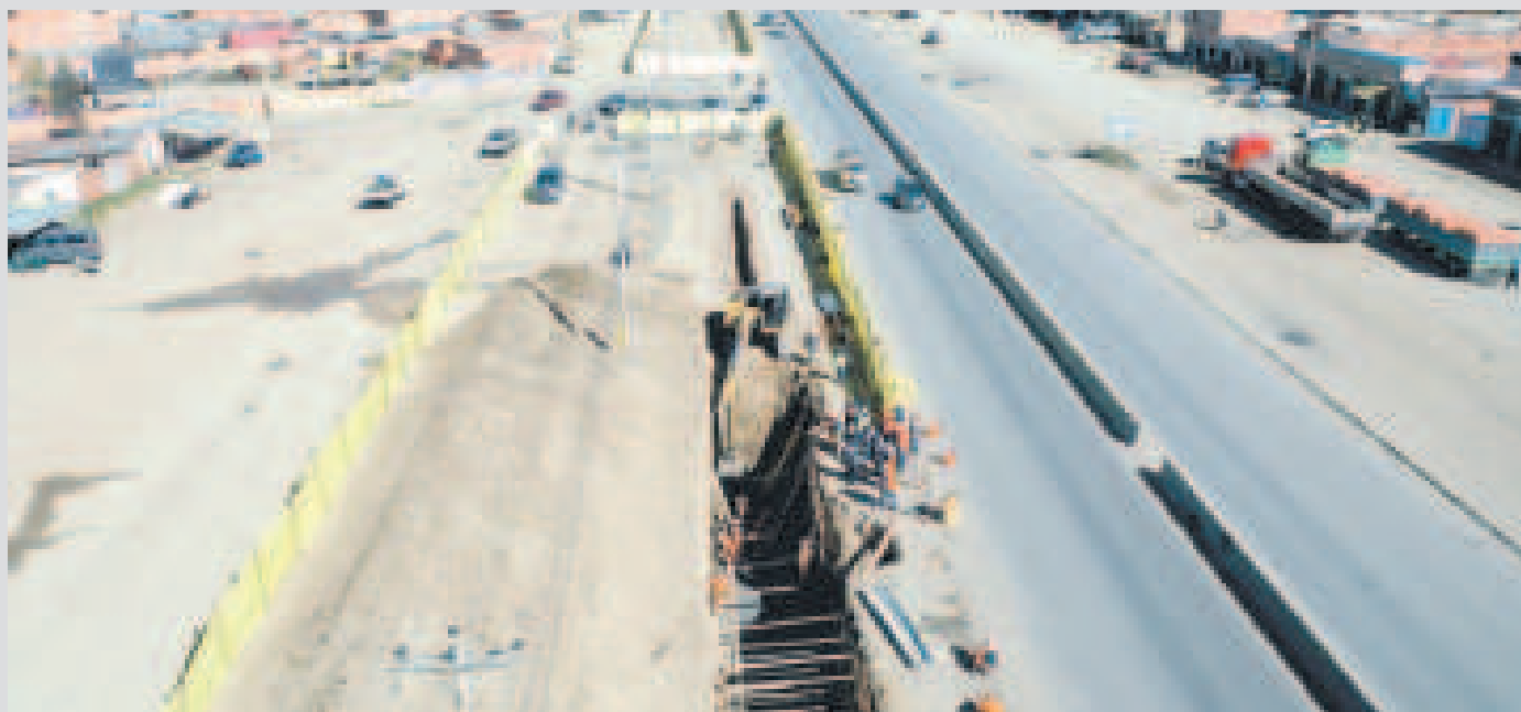
Los trabajos en una de las carreteras del municipio de El Alto.
