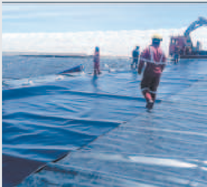
Preparación de las piscinas industriales en el salar de Uyuni.
