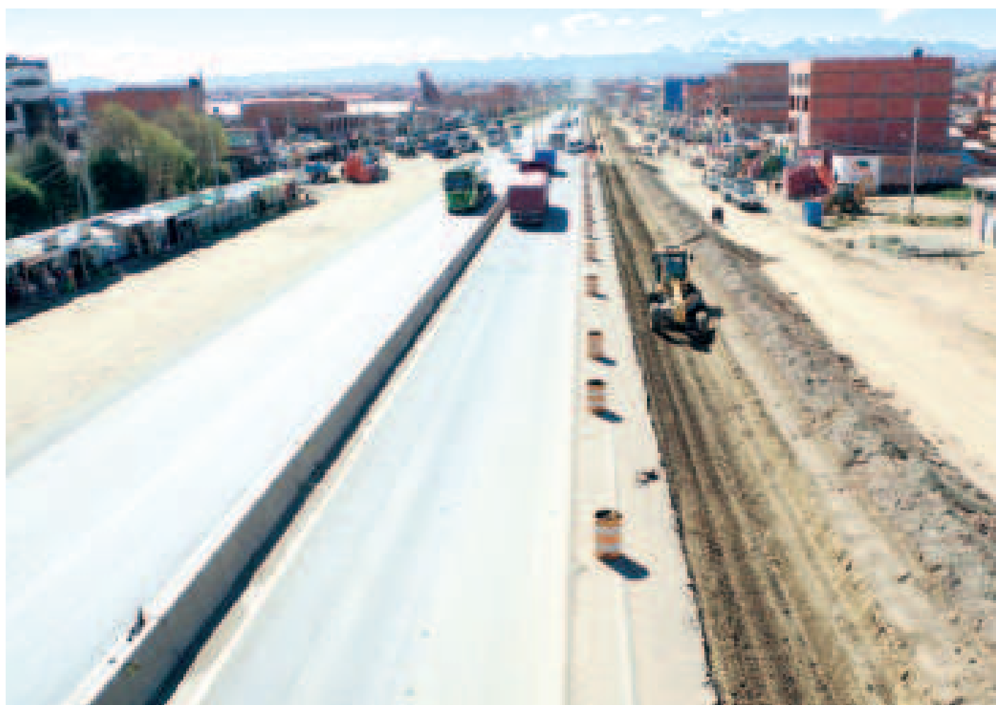
Una vía en construcción.
