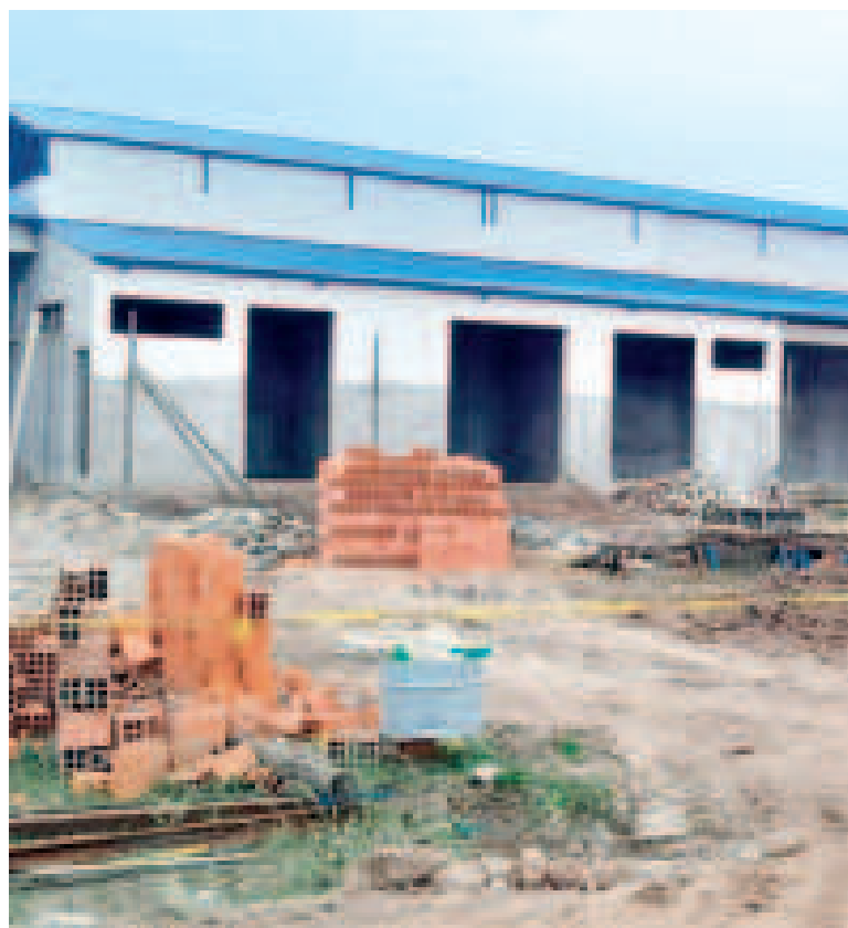
Una vista de las obras de la planta en Bermejo.
