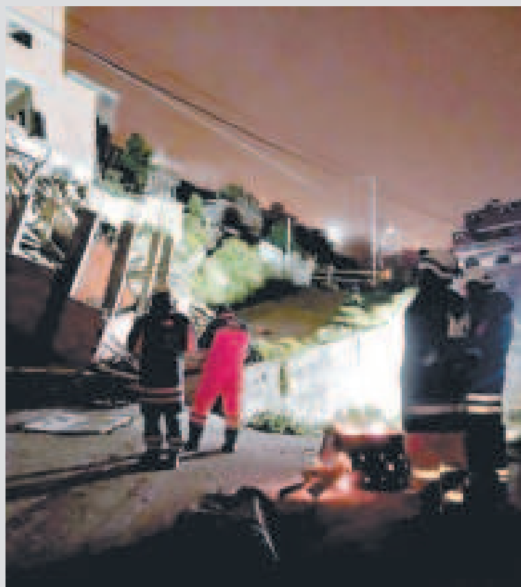
Lluvias provocan colapso de viviendas en Bajo San Isidro, en La Paz.
