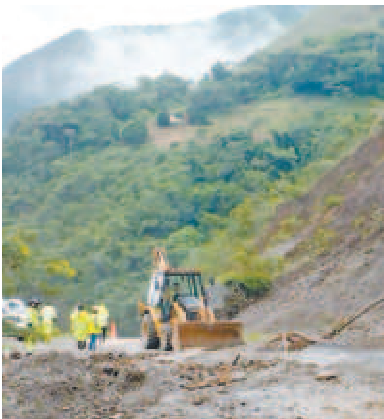
Obreros y maquinaria de la ABC operan para habilitar un camino en Yungas.
