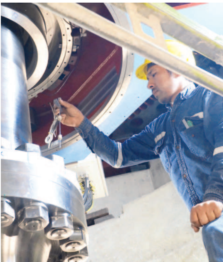
El alineado de precisión de los ejes de turbinas de la central Juntas.
