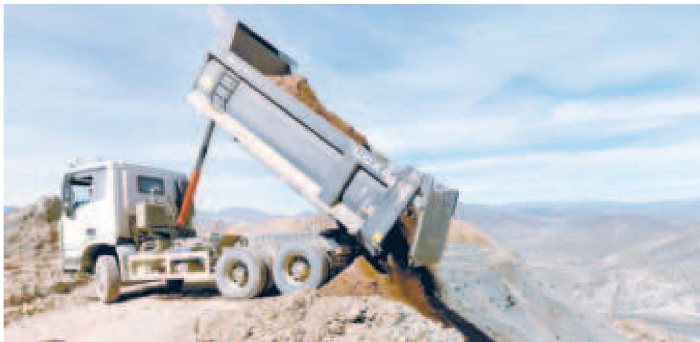
El vaciado de una volqueta con relleno seco a uno de los hundimientos en el cerro.
