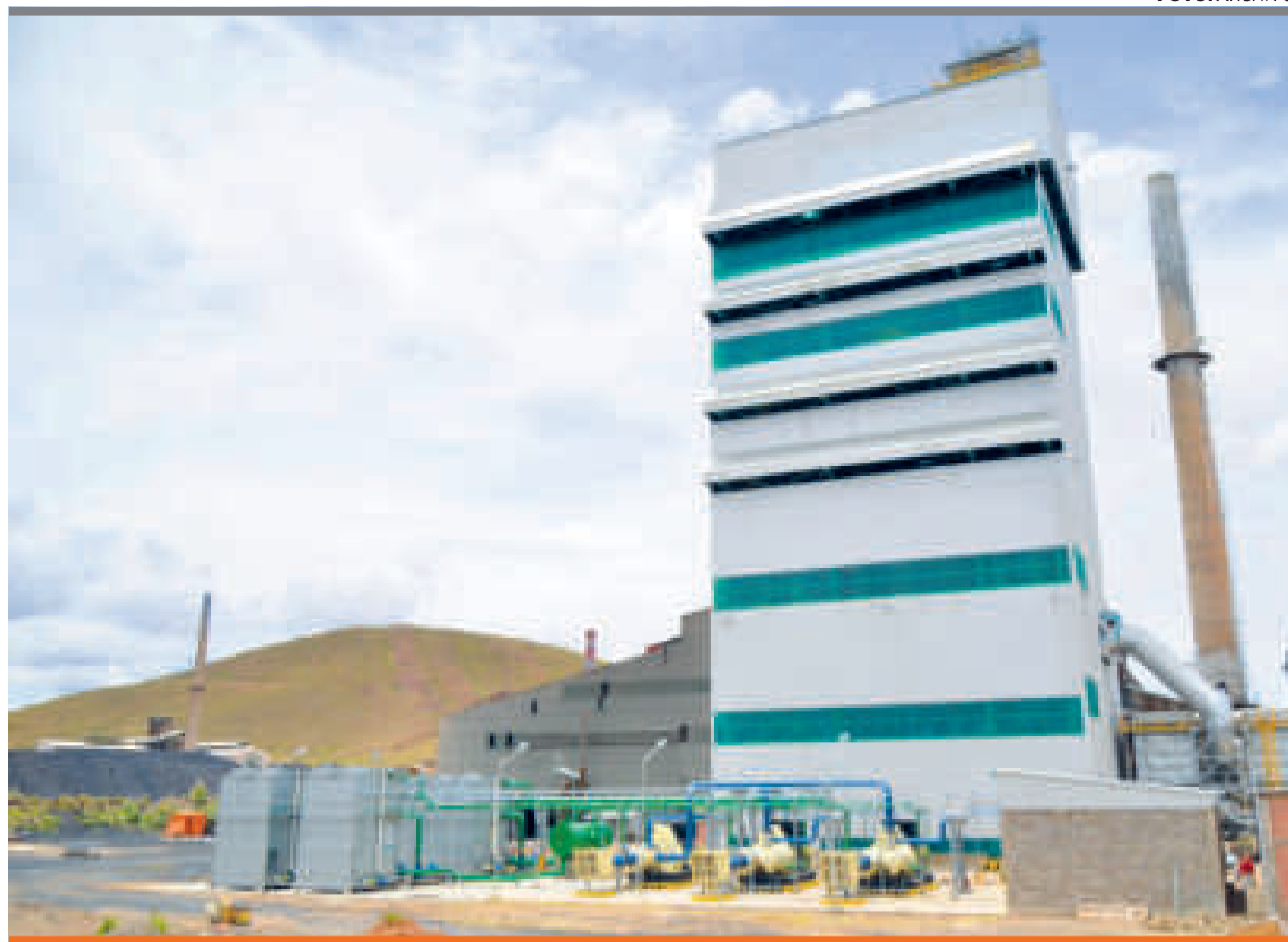
● La metalúrgica Vinto, donde se emplazará la nueva planta, está ubicada en Oruro.
