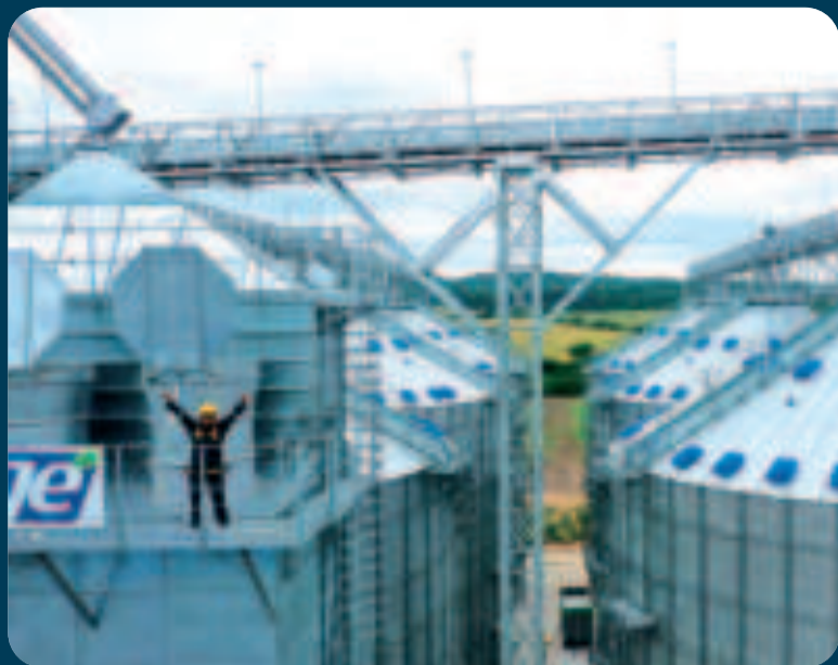
▲ La planta de Yacuiba es una de las edificadas en Tarija.
