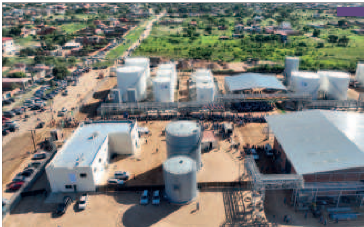
La factoría cuenta con 34 tanques con capacidad de 6,4 millones de litros para recepción y 3,1 millones de litros para despacho de combustibles.
