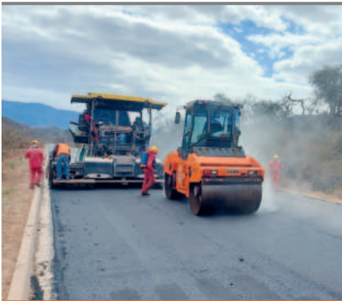
● Trabajos en la construcción de carreteras del país.
