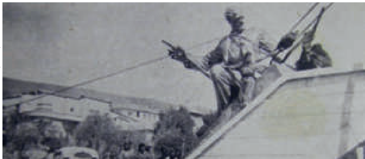
Foto: Instalación del Monumento, La Paz, 1952
